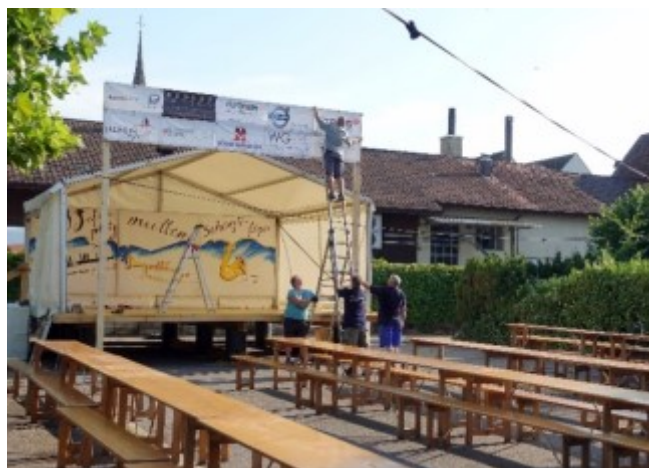
Installationen MuttENZA - Parkplatz
